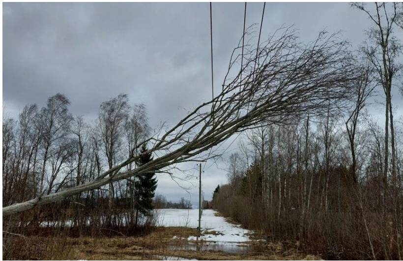
5.1. attēls. Vēja radīti bojājumi elektrolīnijai
